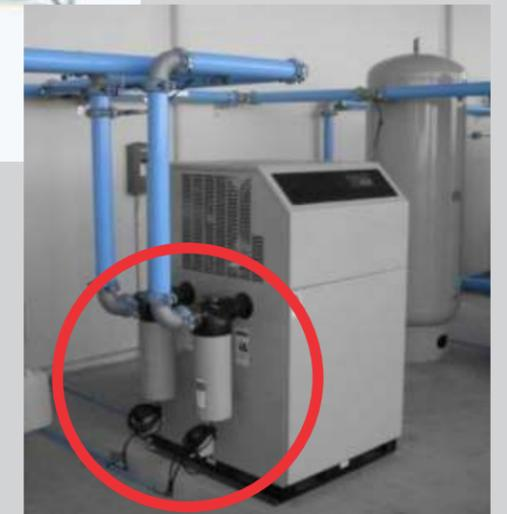
A norma internacional ISO 8573 exige a instalação de um pré-filtro e um pós-filtro coalescentes junto ao secador por refrigeração.
